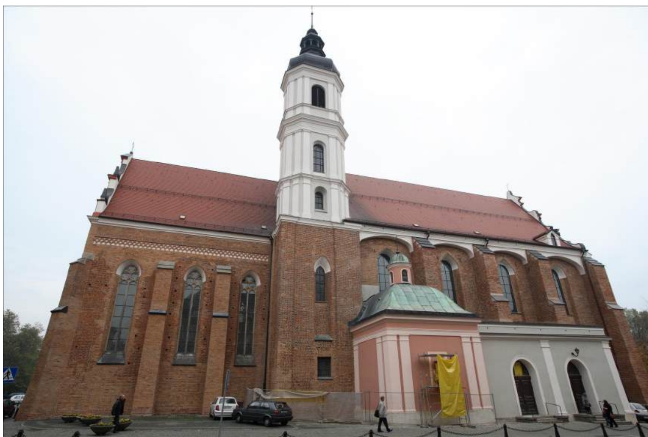
fot. 7. Kościół franciszkanów w Opolu. Widok od strony północnej.
