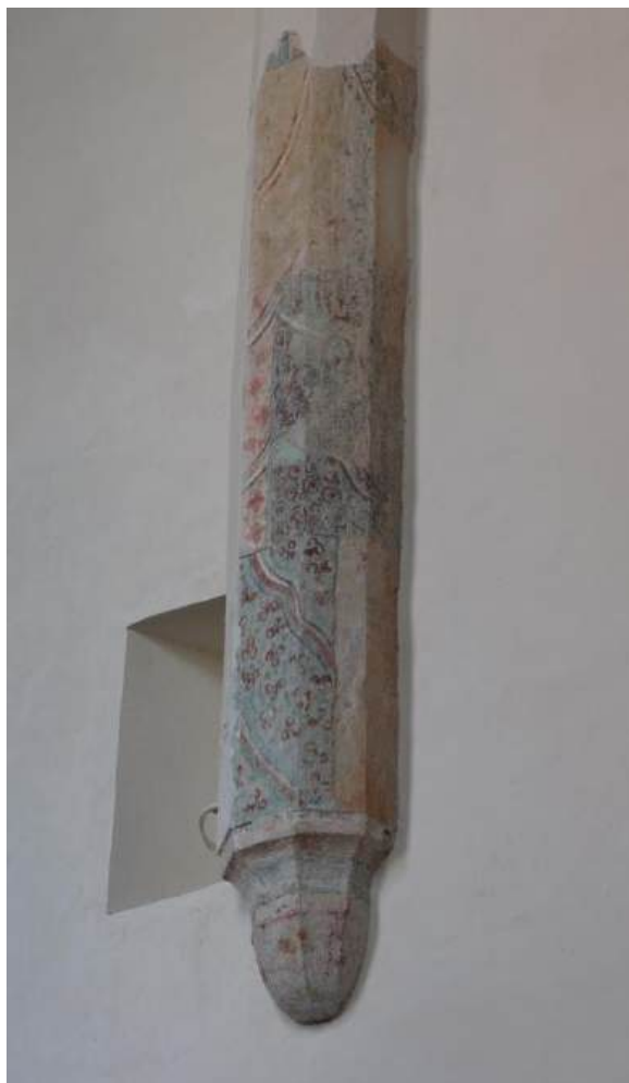
fot. 8. Polichromowana służka sklepienia na południowej ścianie prezbiterium
